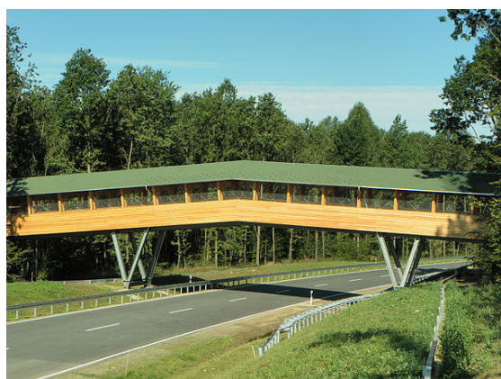
„Haselmausbrücke“ über die südwestliche Ortsumfahrung
