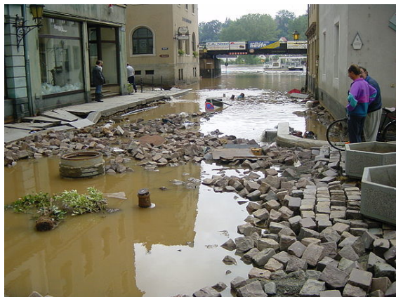
Die von den Wassermassen der Gottleuba zerstörte Dohnaische Straße am 14. August 2002
