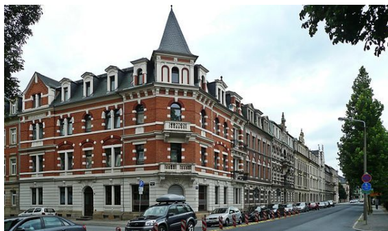
Typische Gründerzeitbebauung in der Westvorstadt (Maxim-Gorki-Straße)
