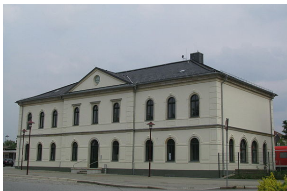
Bahnhofsgebäude nach dem Rückbau, 2010
