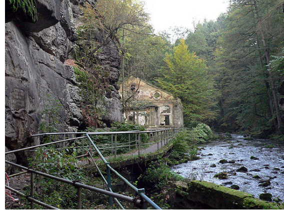
Copitzer Elektrizitätswerk im Liebethaler Grund
