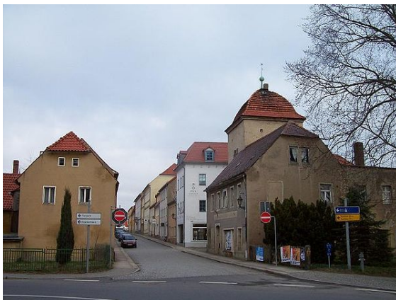
Ehem. Dresdner Tor mit Turm der Fronfeste von 1286
