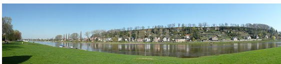
Austritt der Elbe aus dem Elbsandsteingebirge in Pirna, links im Hintergrund die Stadtbrücke Pirna
