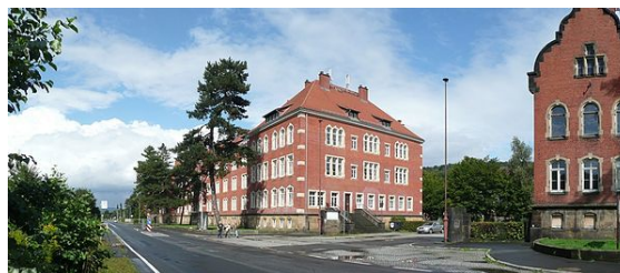
Blick auf die 1905/1906 erbaute Rote Kaserne an der Rottwerndorfer Straße, links der Straße verlief die Gottleubatalbahn
