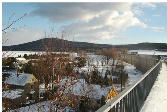
Viadukt über das Wesenitztal; im Hintergrund der Hohwald mit dem Valtenberg
